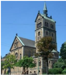
St. Maria Zentrales Pfarrbüro Kirchweg 71, 34119 Kassel
